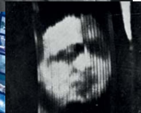
« **La prima immagine trasmessa in TV, 2 ottobre 1925** Il volto del fattorino inglese William Taynton fu riprodotto in 28 linee grigie, con una frequenza di 5 immagini al secondo, tramite un sistema a scansione meccanica.
