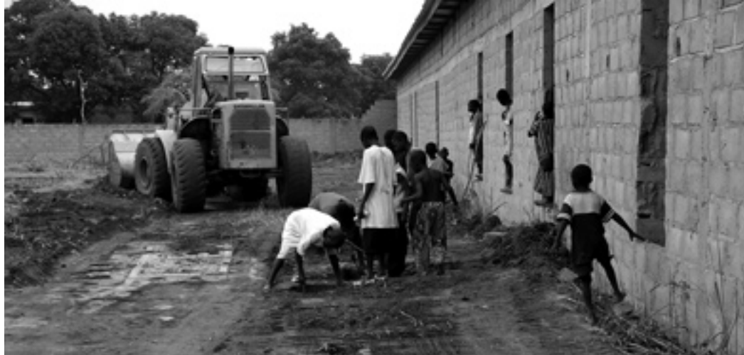
► A sinistra: Ruspa al lavoro per il livellamento del terreno; sotto: Donne e bambini ospiti dei centri dell'Associazione S. Camillo
