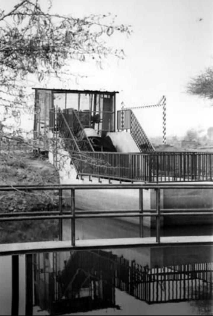
► **Idrovora:** pompa a motore (gasolio) per l'elevamento dell'acqua dai fiumi ai canali di irrigazione
